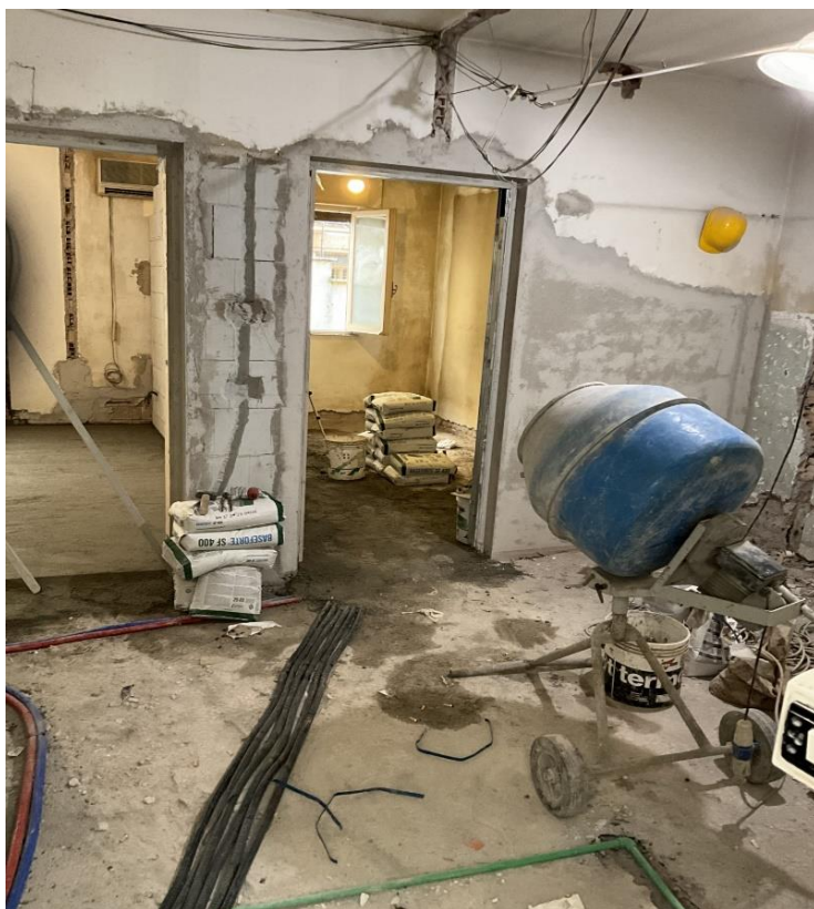
Lavori di adattamento in corso
