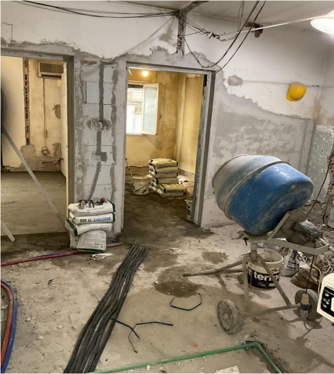
Lavori di adattamento in corso
